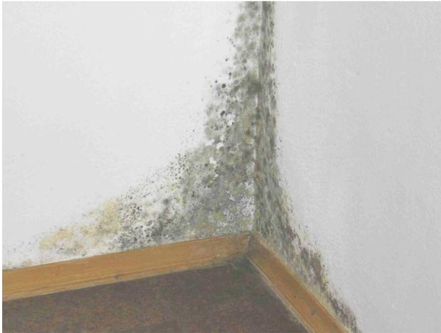
In unseren dichten Gebäuden, die heute meist auf eine gute Wärmedämmung ausgerichtet sind, ist mangelnde Lüftung fatal. Die Feuchtigkeit, die täglich durch Duschen, Waschen und Kochen abgegeben wird, kann nur in geringer Menge von der Luft aufgenommen werden. Ist eine Wand ausreichend kalt, so schlägt sich der Wasserdampf unbemerkt dort nieder und führt langfristig fast zwingend zu einem Pilzbefall.
